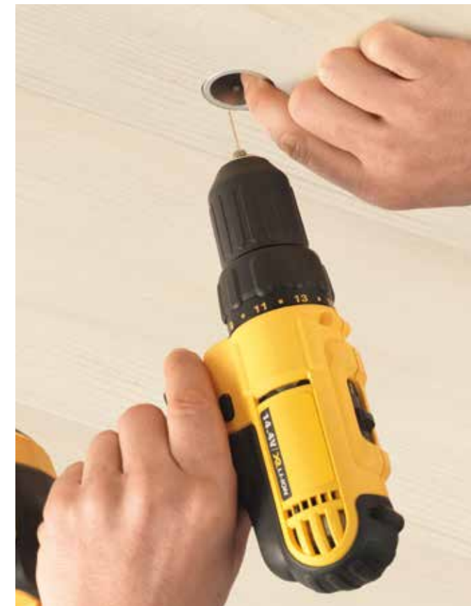
Montage HOLZEINBAURING 28.
