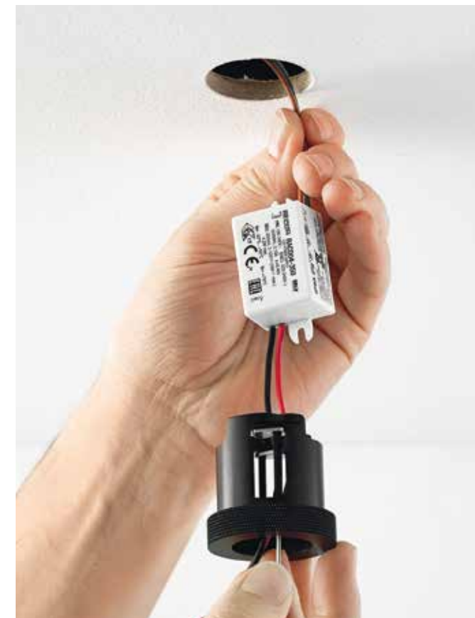
Montage RENDEL 28 mit Mini-LED-Treiber.
